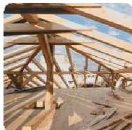
3. Structure, maçonnerie, gros œuvre, charpente
