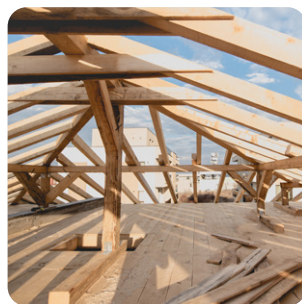
3. Structure, maçonnerie, gros œuvre, charpente
